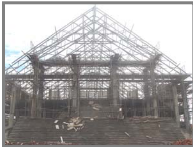
โครงสร้างอาคารหอประชุมแห่งใหม่
